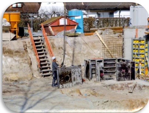
Đưa phần cốt pha vào vị trí trong hố
