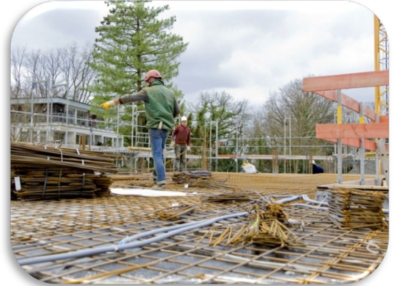
Xếp cốt thép lên tấm gỗ trần thô
