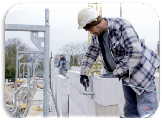
Xây tường từ gạch khối
