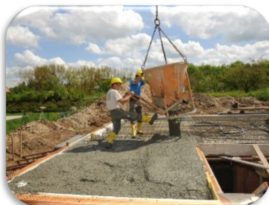
Rót bê tông trên mái tầng hầm với cần cẩu
