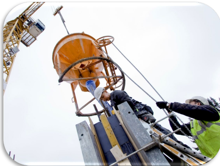
Đưa bê tông từ bể chứa vào cột cốt pha
