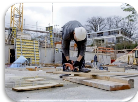
Cắt tấm cốt pha với máy cưa tròn
