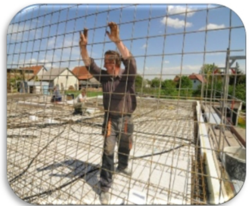
xếp đặt tấm cốt thép trên trần nhà cao tầng
