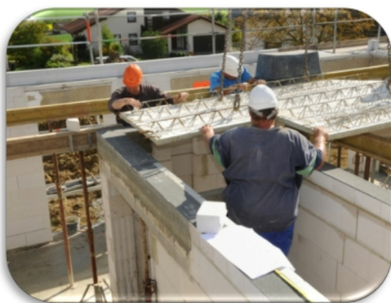
Xây lắp chính xác cấu kiện trần nhà
